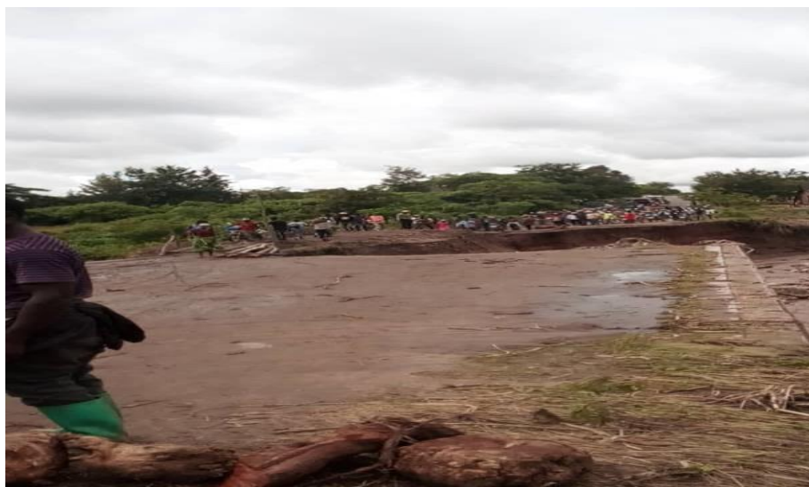
Sur l'avenue Mulongwe toute les maisons et personnes emportées par les eaux de la rivière Mulongwe ou l'avenue est effacée.
