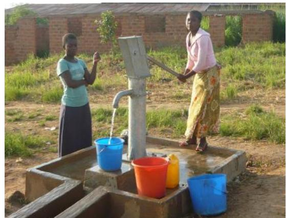
Modèle de pompe manuelle à installer dans les villages n'ayant pas des sources ni puits d'eau à aménager
