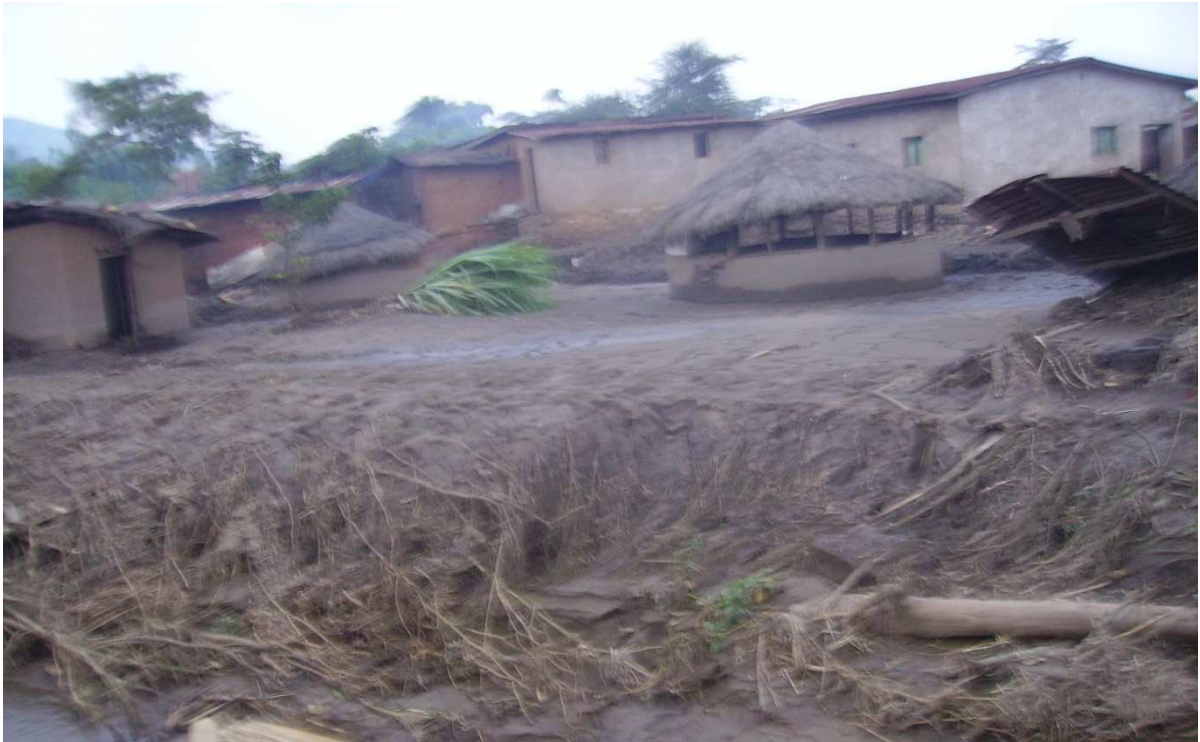
Voici les maisons des pauvres villageois détruites et emportées
