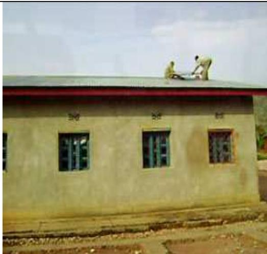
Des techniciens en travail d'électrification solaire du centre de centre de santé de ZINA. Sur cette photo : Le placement des panneaux solaire sur le toit du centre de santé.
